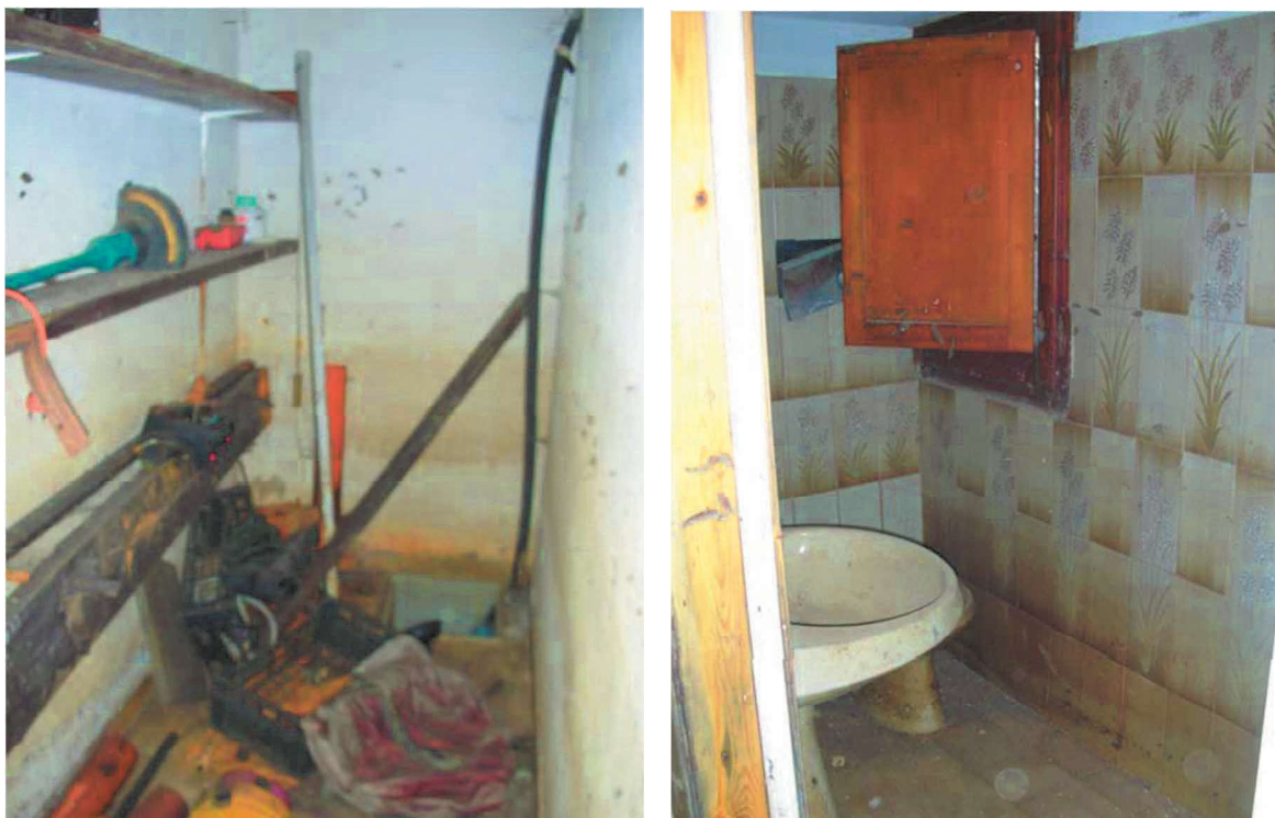
Foto n. 27 – Particolare sgabuzino e bagno al piano scantinato
