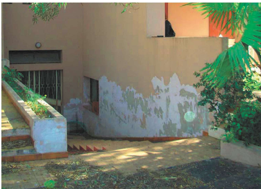
Foto n. 23 – Particolare rampa di ingresso al piano scantinato
