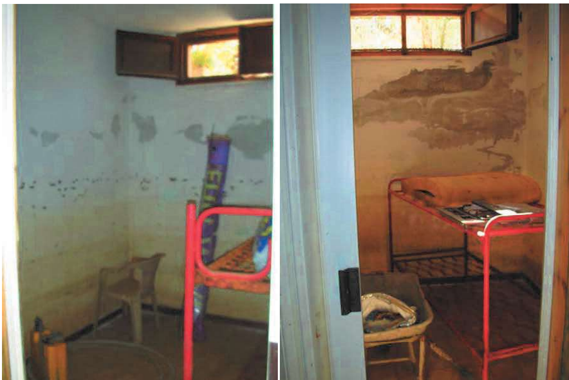
Foto n. 26 – Particolare lavanderia e ripostiglio al piano scantinato
